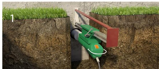
Алмазное сверление фундамента для прокладки канализационного трубопровода.
